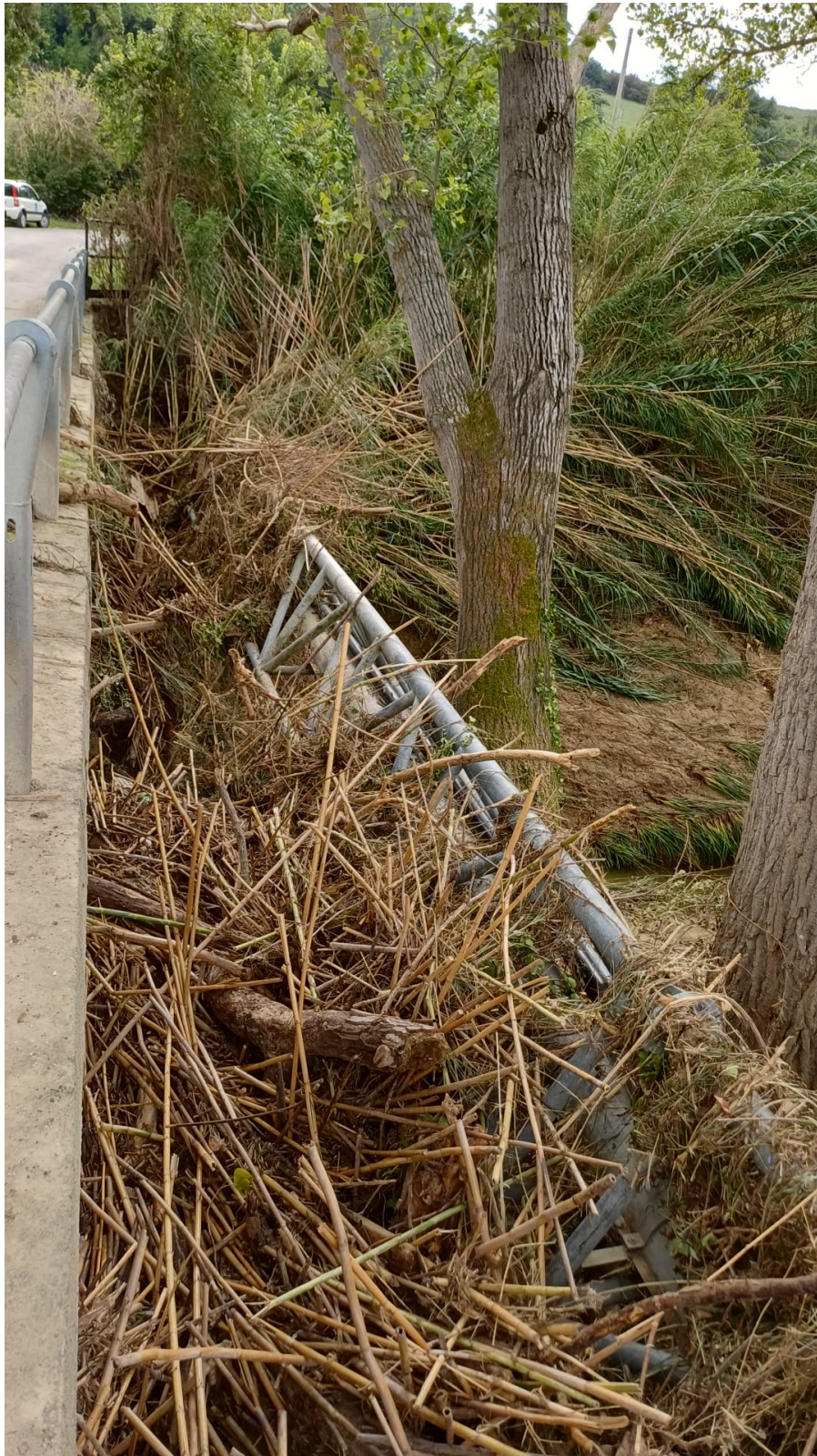
Figura 38: segni evidenti dell'esondazione del fosso in località Via Saline in data 23 settembre 2024
