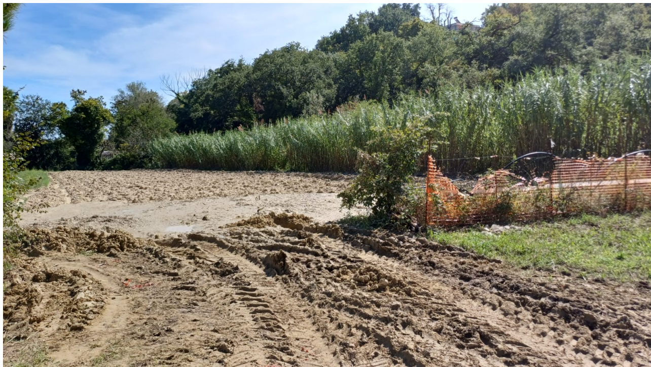
Figura 43: fango e allagamenti in zona Rustichello, San Benedetto del Tronto
