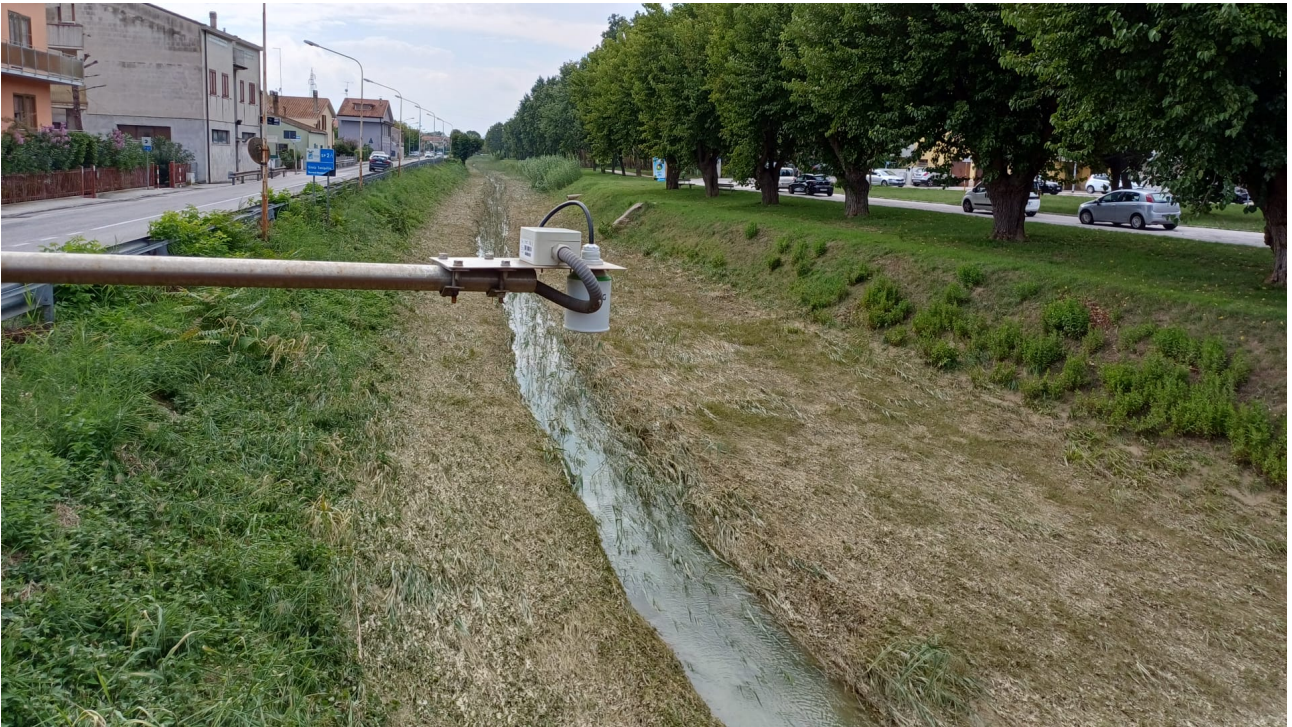
Figura 29: Stazione di Montemarciano in data 23 settembre 2024. Traccia dell'onda di piena.
