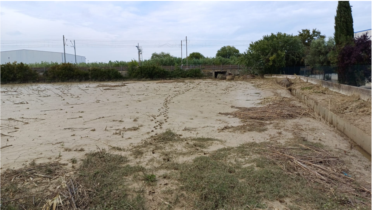
Figura 31: Castelferretti allagamenti Via del Consorzio - 23 settembre 2024.
