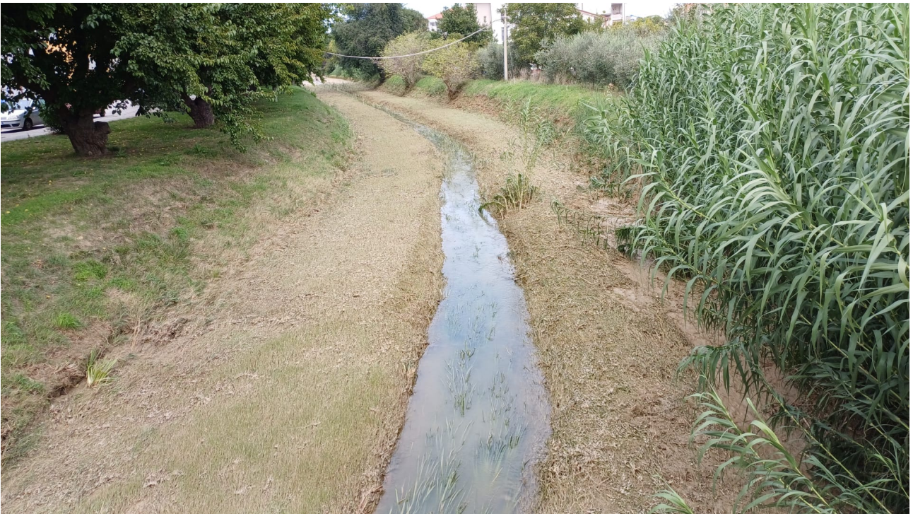
Figura 30: Stazione di Montemarciano in data 23 settembre 2024. Traccia dell'onda di piena.
