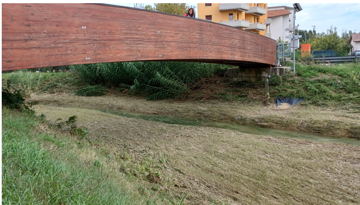
Figura 28: Stazione di Montemarciano in data 23 settembre 2024. Traccia dell'onda di piena.
